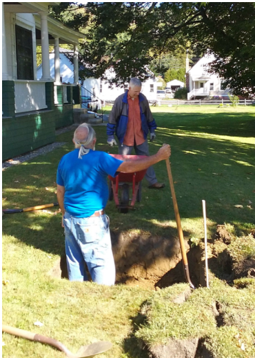
Brent and Dan dig the hole.
